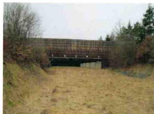
Foto 2: Zielaufbau des Gewehrschießstandes mit beidseitigen Schutzwällen
